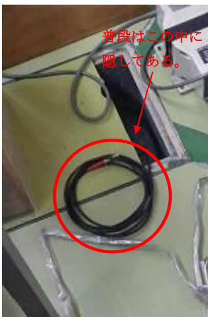
写真5 実験室内のケーブル
