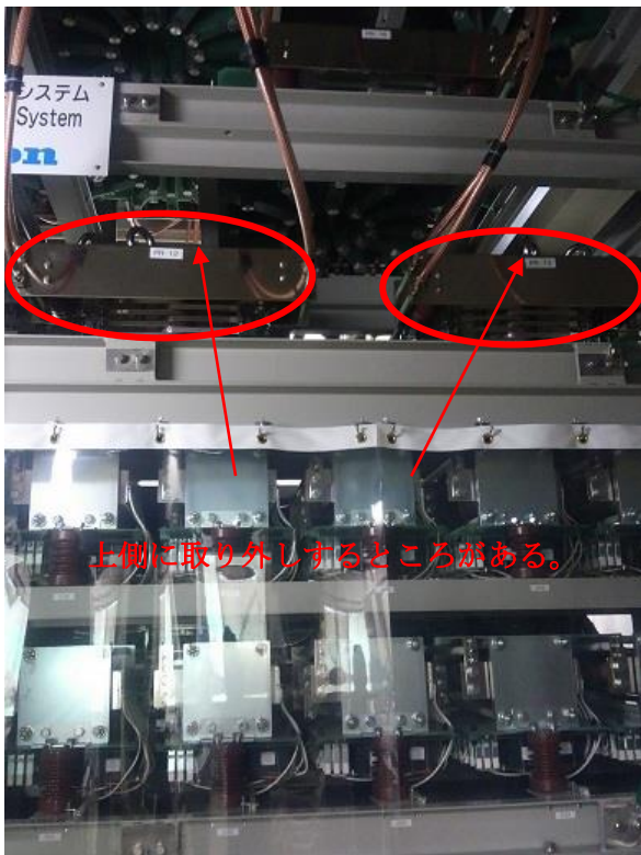
写真1 クローバー回路ユニット全体
